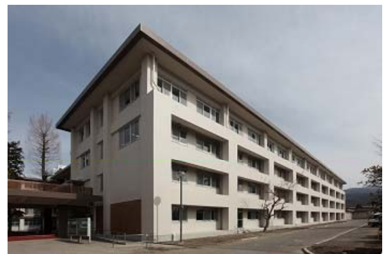
松本キャンパス全学教育機構南校舎等の改修。耐震補強及び機能改善整備を行いました。
