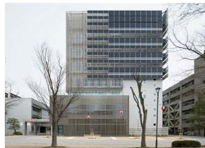
信州大学国際科学イノベーションセンター竣工
